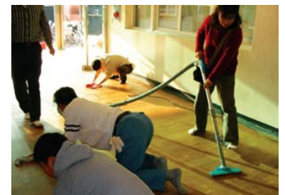
Inisiat Gwangju memasang lantai baru untuk gedung Rumah Kebangkitan.
